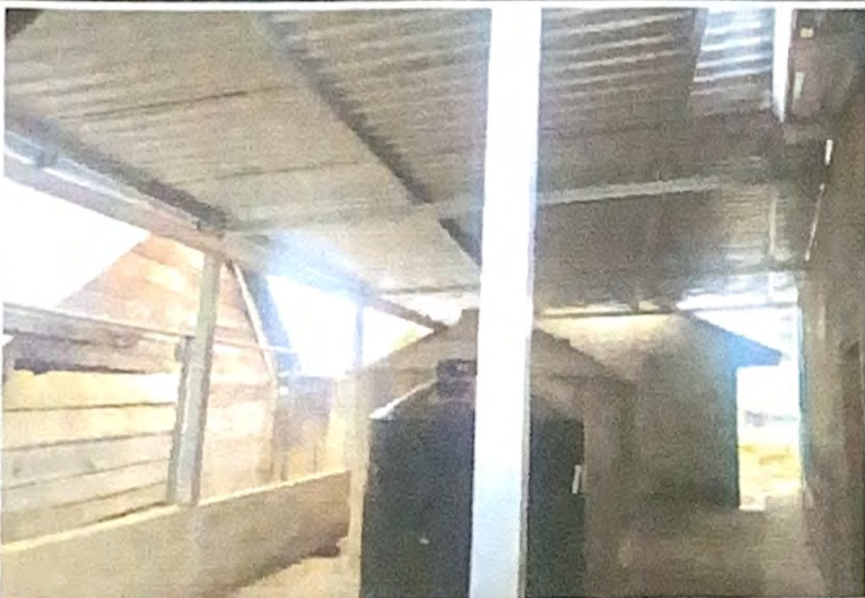
Foto 3: Se entecho el lugar de los tinacos.
