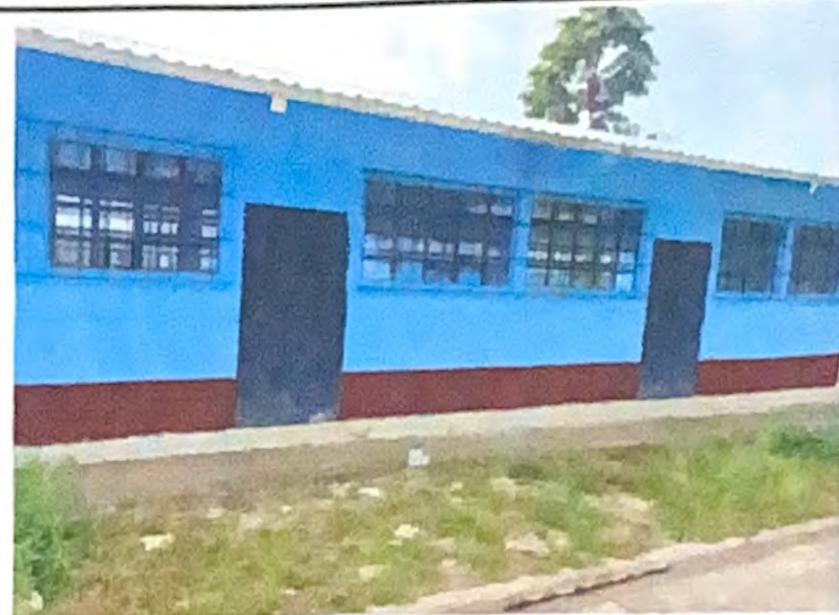
Foto 2: Se colocó los balcones y se colocó las puertas.
