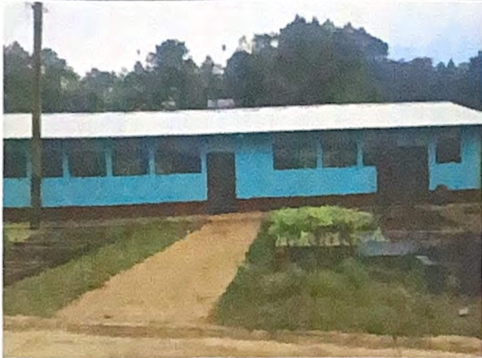
Foto1: Se pinto la escuela y las aulas.
